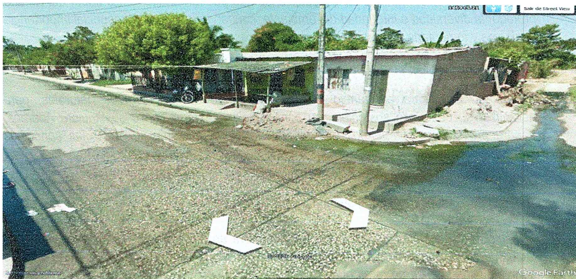
Figura 4. Evidencia la acumulación vertimientos líquidos en vía pública (imagen Google Earth).
